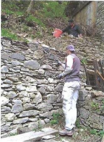
Bis Ende Mai werden die Mauern in Altfinstermünz einer Überprüfung unterzogen und Mauerkronen und Fehlstellen im Gemäuer saniert.
