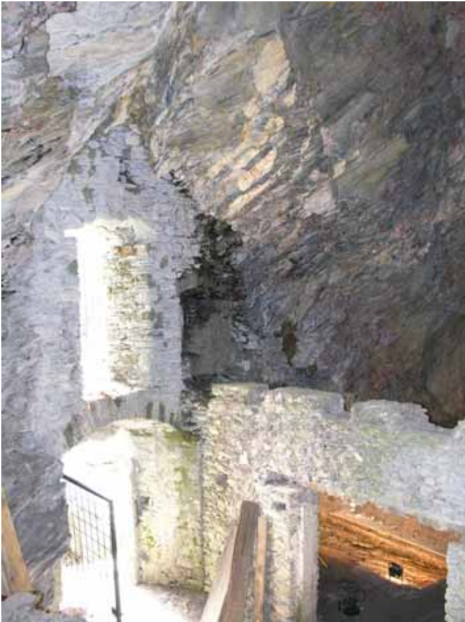
Abb. 6: Eingangsbereich (links) der Höhle von innen (Raum F.0.2) gesehen, rechts Trennmauer zu R. F.0.1.
