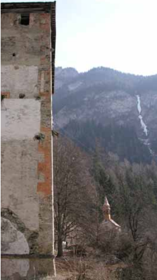
Abb. 14: Altfinstermünz 2004. Blick nach Südosten am Klausenturm vorbei zur Kapelle Mariä Himmelfahrt.
