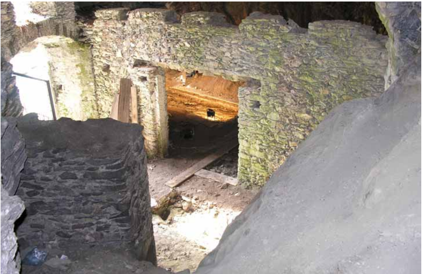
Abb. 8: links Eingangsbereich der Höhle vom östlichen Kamin aus gesehen, Blickrichtung SW, Mitte Trennmauer zu R. F.0.1 mit Blick auf die Sondage F-I/7, Ausnehmungen für die Deckenbalken, links unten teils frei stehende Mauerscheibe mit Nischen an der Gegenseite, vermutlich in Zusammenhang mit der Küchennische zu sehen (links davon).
