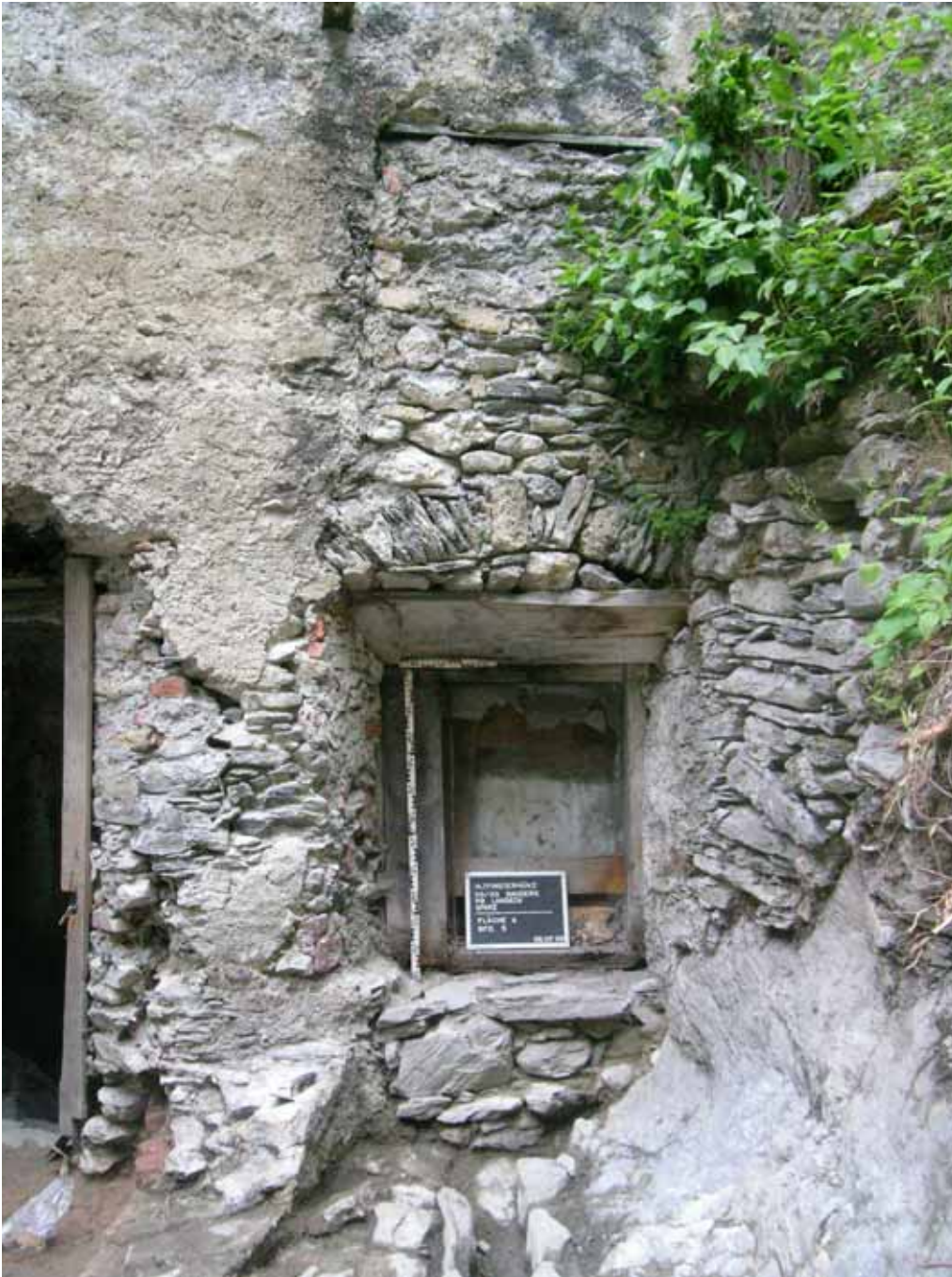
Abb. 26: Altfinstermünz 2005. Fensteröffnung in der östlichen Sperrmauer, links unten die übereck laufende Verputzung des Backofens, die Brüstungsmauer als Zusetzung einer ehem. Türöffnung zum Laufgang in die „Bastei“ entsprechend schmaler als die heutige Fensteröffnung, oben eine weitere, zugesetzte Öffnung, unten Teile eines Abflusskanals, die Türlaibung links ebenfalls sekundär entstanden,
