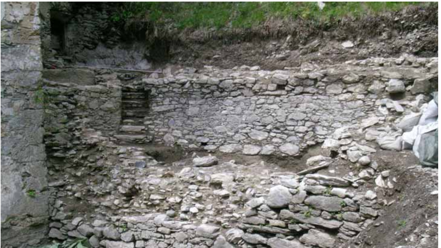
Abb. 19: Altfinsternmünz 2005. Blick auf die Reste der „Bastei“ nordöstlich des Torturms, hinten Treppe zum ehemaligen Verbindungsgang zur Burg, dahinter der für diesen Gangbau abgearbeitete Fels, links der Zwickel zwischen Basteimauer und Turm abgemauert, dahinter erkennbar die noch etwas höher herausragenden Reste des Backofens, rechts die östliche Begrenzung der „Bastei“, an der Nordmauer gut erkennbar der Ansatz zum Gewölbe.
